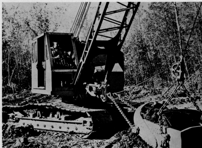
L'apprentissage sur la machinerie lourde de construction.
