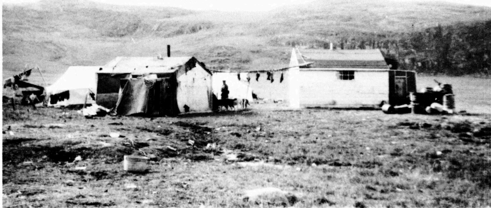
MAISONS CONSTRUITES AVEC DU BOIS DE REBUT Cinémathèque du Bureau de recherches scientifiques sur le Nord Arctique de l'Est
