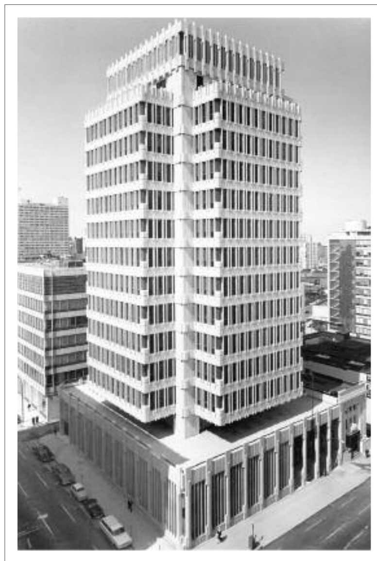
L'Agence de Vancouver, 1966, représentation artistique et photo de l'immeuble achevé. Établie à l'intersection des rues Hastings et Hornby, elle a été conçue par le cabinet de Thompson, Berwick et Pratt de concert avec la firme de Durnford, Bolton, Chadwick et Ellwood. La façade classique du bâtiment d'origine a été préservée lors de la construction de la tour cruciforme de quatorze étages.
