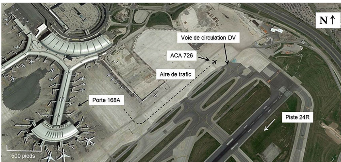
Figure 1. L'ACA726 sur l'aire de trafic à la hauteur de la voie de circulation DV (Source : Google Earth, avec annotations du BST)
