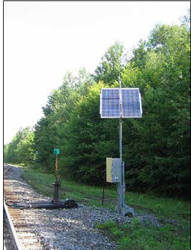
Figure 4. Détecteur de position d'aiguille
