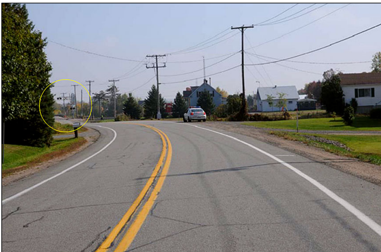
Figure 7. Vue à environ 800 pieds de distance du passage à niveau (Source : Sûreté du Québec)
