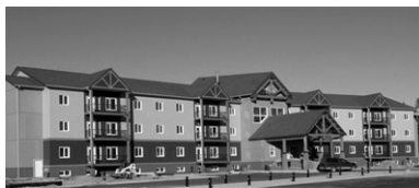
Construction du Village des athlètes
