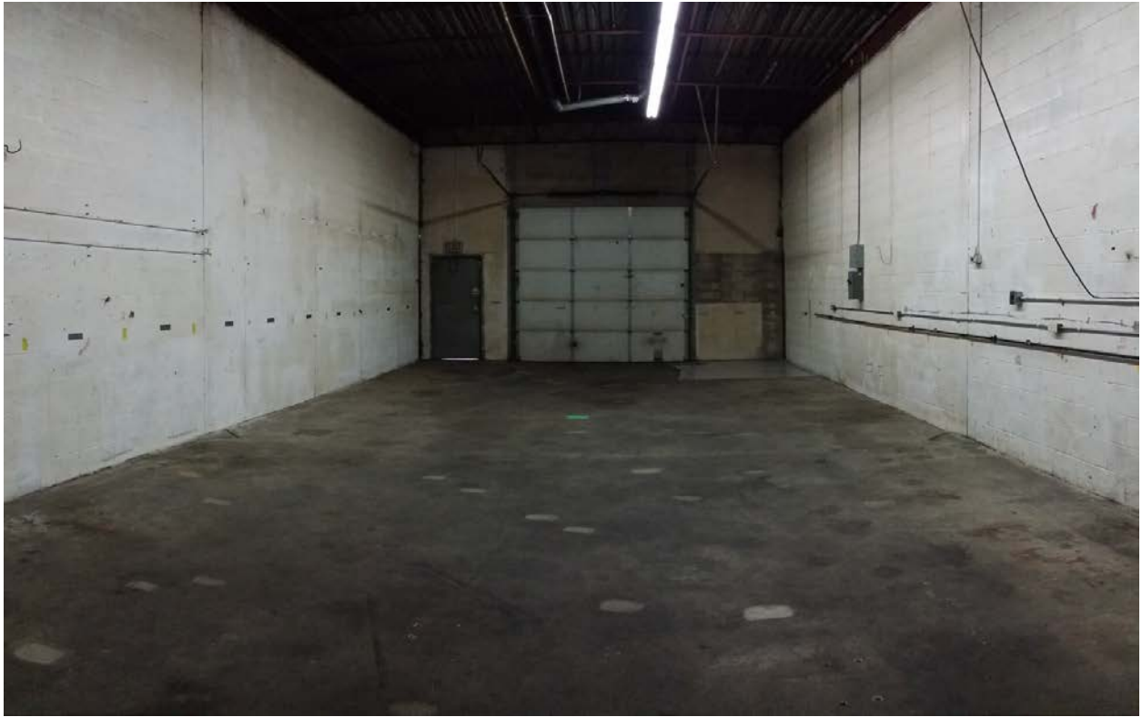
Figure 2 : Entrepôt de RMR après la décontamination
