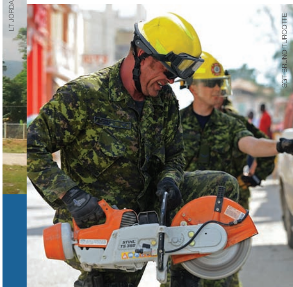
Le Cpl Eric Chafe, (à gauche) pompier de la 8 e Escadre Trenton (Ont.), se sert d'une scie à béton pendant la démolition d'une maison effondrée. Les pompiers ont rempli de multiples rôles au sein de l'Équipe d'intervention en cas de catastrophe.
