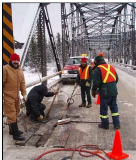
Réparation du pont Moberly, février 2008
