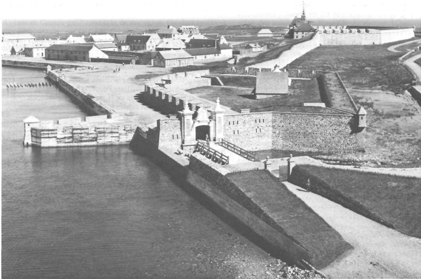
1 Vue sud-est de la forteresse reconstruite, soit un cinquième de la ville historique fortifiée. À l'avant-plan, la porte Dauphine.
