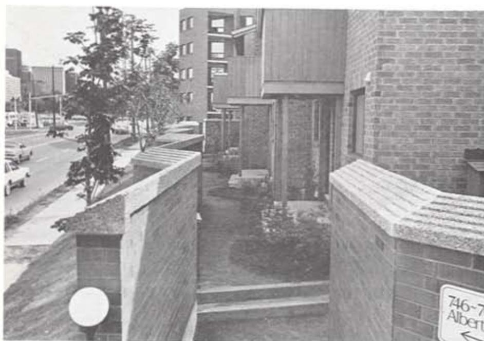
L'efficacité anti-bruit de chaque mur a été mesurée par le Conseil national de recherches. Le tableau ci-après donne la hauteur du mur, les coordonnées pertinentes, les particularités de la construction et le résultat de l'évaluation.
