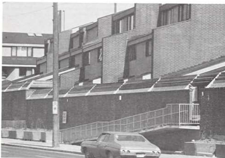
**Le mur de brique anti-bruit est coiffé d'un abat-sons dont les lames diminuent aussi les amoncellements de neige derrière le mur.**
