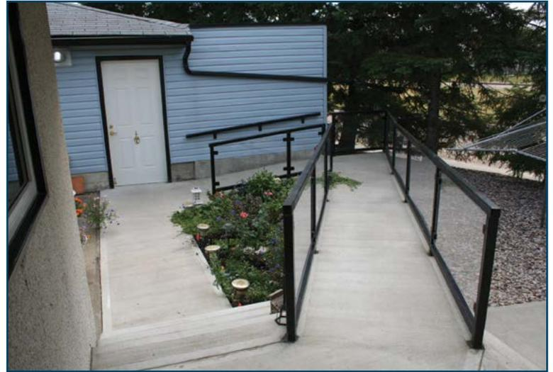
Figure 10 : Rampe d'accès en béton en forme de L
