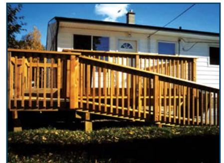
Figure 4 : Rampe d'accès en U
