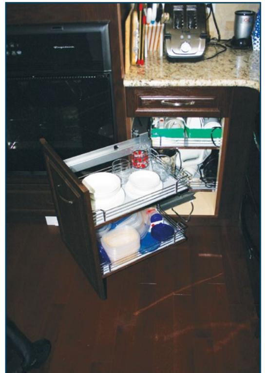
Figure 5 : Tablette coulissante pour appareils de petite dimension et autres articles de cuisine
