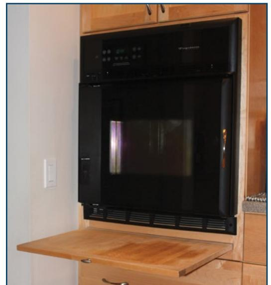
Figure 8 : Tablette coulissante placée sous un four mural
