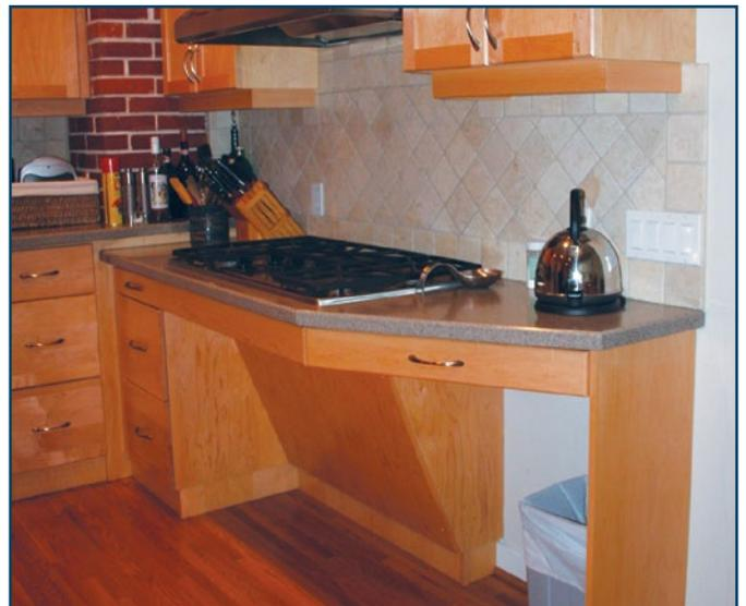
Figure 7 : Surface de cuisson dans une cuisine accessible
