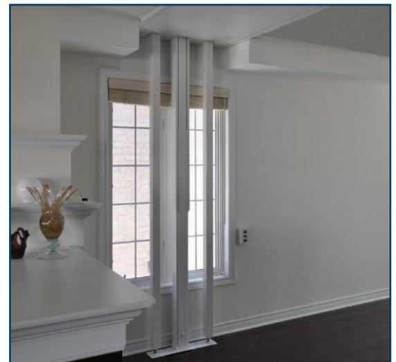
Figure 8 : Ascenseur sans puits complètement monté à l'étage
