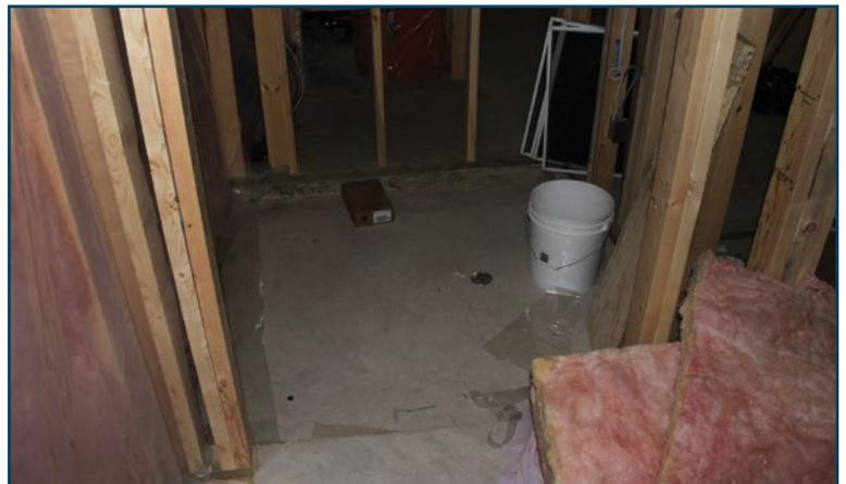
Figure 6 : Dépression dans le plancher de béton sous la cage de l'ascenseur
