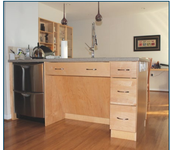
Figure 16 : Robinet avec tuyau d'arrosage rétractable au-dessus de l'îlot de cuisine Photo : Ron Wickman
