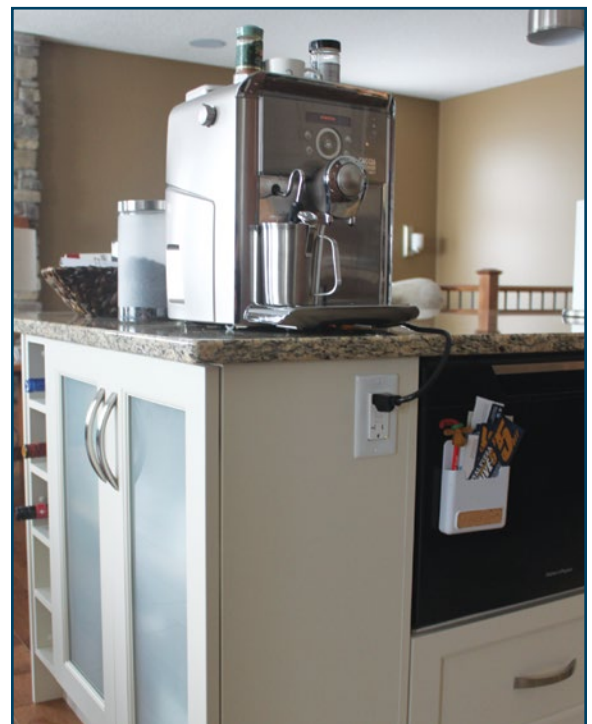
Figure 17 : Prise de courant sous le comptoir Photo : Ron Wickman
