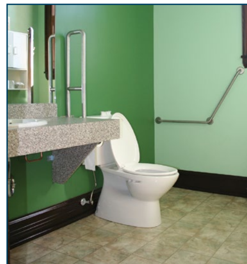
Figure 17 : Les barres d'appui rabattables ne restreignent pas l'utilisation de la salle de bains
