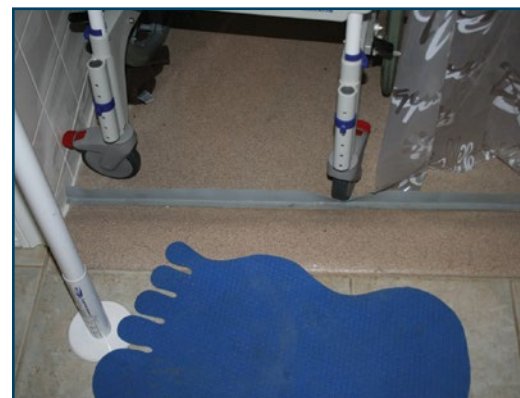
Figure 9 : Membrane étanche à l'entrée de la douche
