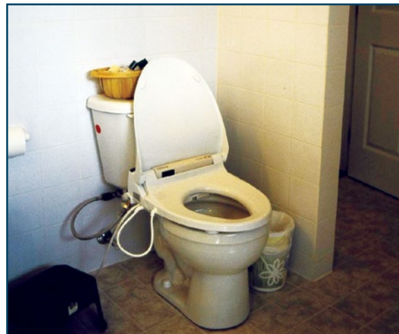
Figure 13 : Toilette avec bidet intégré et séchoir Photo : Ron Wickman
