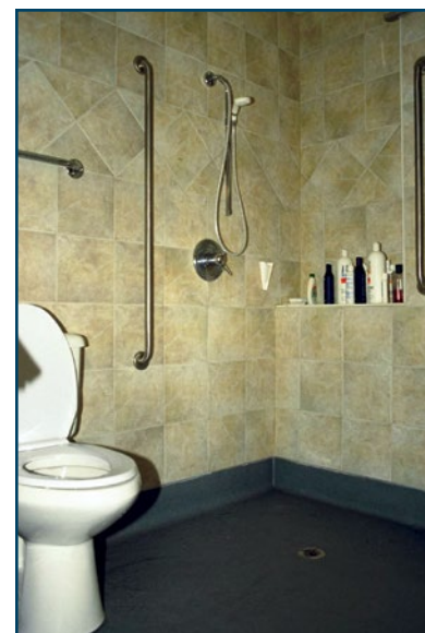
Figure 6 : Toilette située près de la douche de plain-pied Photo : Ron Wickman
