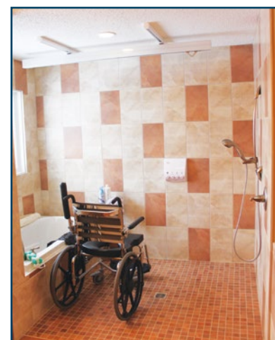
Figure 5 : Salle de bains avec douche spacieuse de plain-pied et baignoire. À noter : le dispositif de transport à coulisse fixé au plafond.
