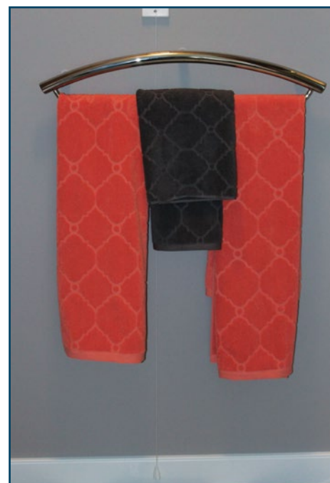
Figure 8 : Porte-serviettes pouvant servir de barre d'appui. À noter : Le cordon de secours juste au-dessus du porte-serviettes.
