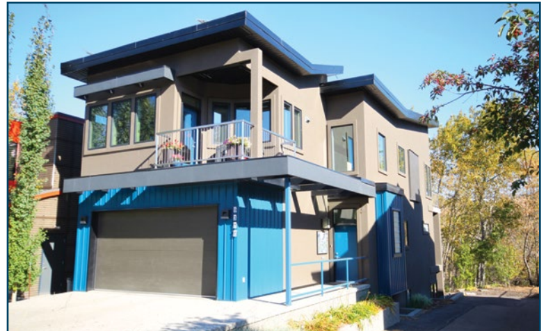
Figure 10 : Habitation accessible personnalisée Photo : Ron Wickman
