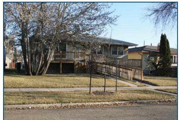
Figure 5 : Maison individuelle avec une longue rampe d'accès menant à l'entrée principale Photo : Ron Wickman
