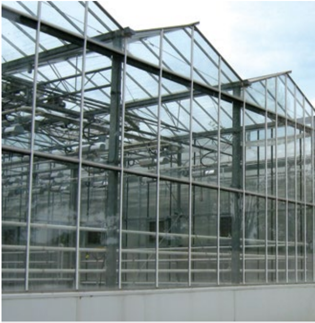
Serre vue de l'extérieur
