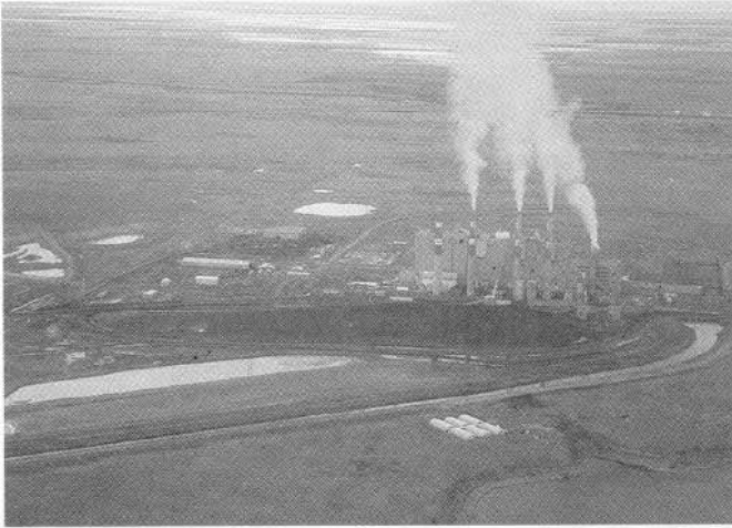
Centrale thermique Boundary, avril 1991 (photo : R. Riewe).
