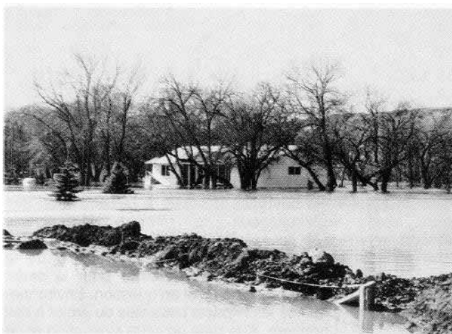
Conséquences de la construction dans une plaine inondable (photo : SBDA)
