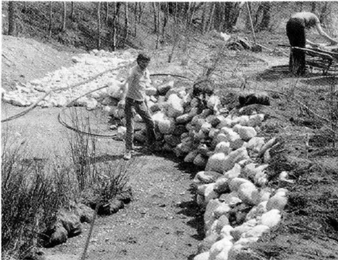
Modification du cours d'une rivière et amélioration de l'habitat du poisson durant le doublement de la route transcanadienne dans le Parc national de Banff.
