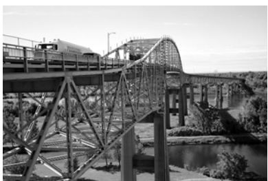
Pont international de la voie maritime, situé à Cornwall
