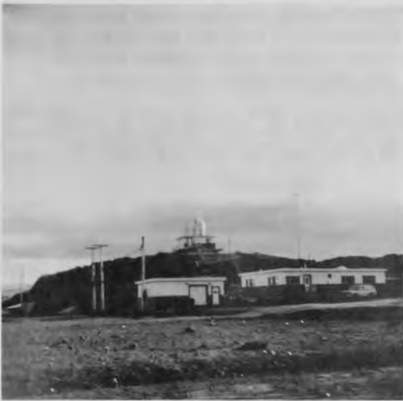
Station d'observation en altitude – GMD-2 Radome.
