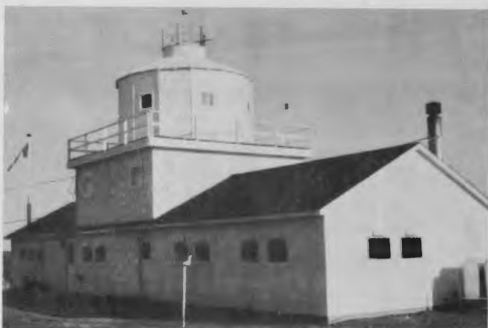
L'édifice où se font les observations d'altitude avec le radiomètre RF 1 sur le dessus de l'ancien dome metox.
