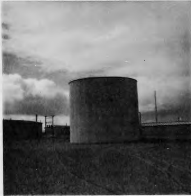
Le réservoir d'une capacité de 200,000 gallons d'eau à Inoucdjouac. The 200,000 gallon water storage tank at Inoucdjouac.
