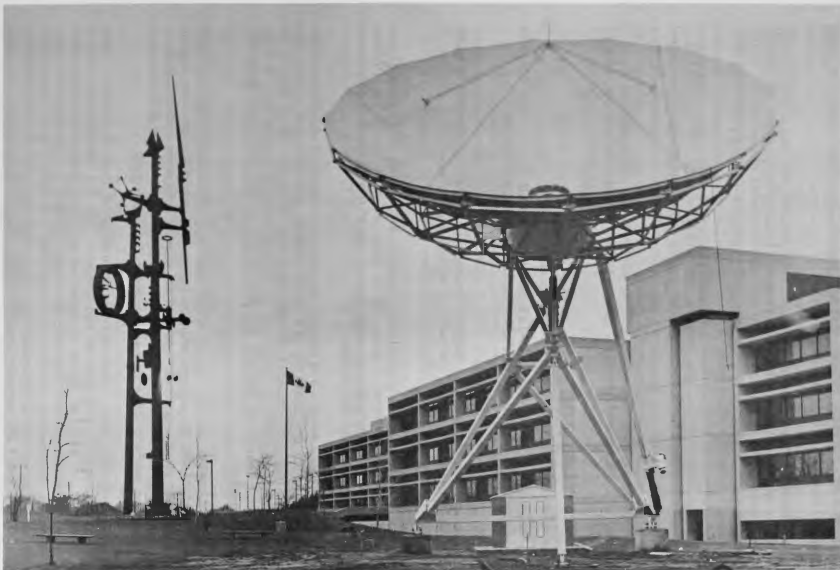
The Atmospheric Environment Service's new satellite antenna installed at the Downsview, Ontario Headquarters. Installation de la nouvelle antenne de réception des données de satellite à l'Administration centrale du Service de l'Environnement atmosphérique à Downsview.
