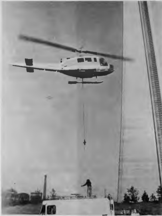
Commencing first lift. La première ascension commence.
