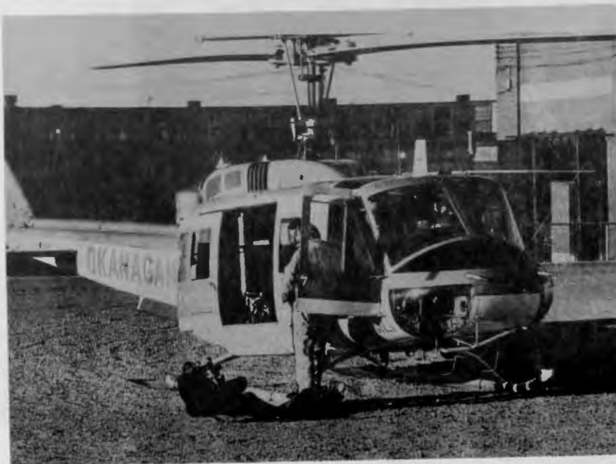
Preparing for lift-off./Préparatifs de décollage.
