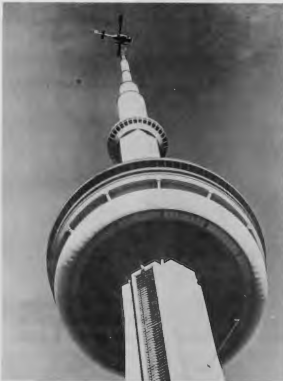
Helicopter poised to ease mast down. L'hélicoptère immobilisé pour l'installation du mât.
