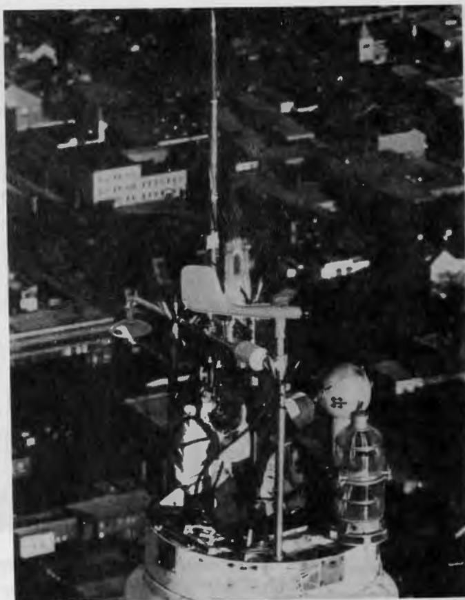
J.S. (John) McLernon, on the 5 foot diameter "lid" of the CN Tower, hangs on with his feet and operates a radio with one hand and with the other hand guides the mast into a hole in the lid. And all this at 1,815 feet above ground! ! Sur le "couvercle" de 5 pieds de diamètre de la tour du CN, M. John S. McLernon qui s'agrippe de ses pieds, fait fonctionner un émetteur-récepteur d'une main et, de l'autre, guide le mât pour le mettre en place. A 1815 pieds du sol! !
