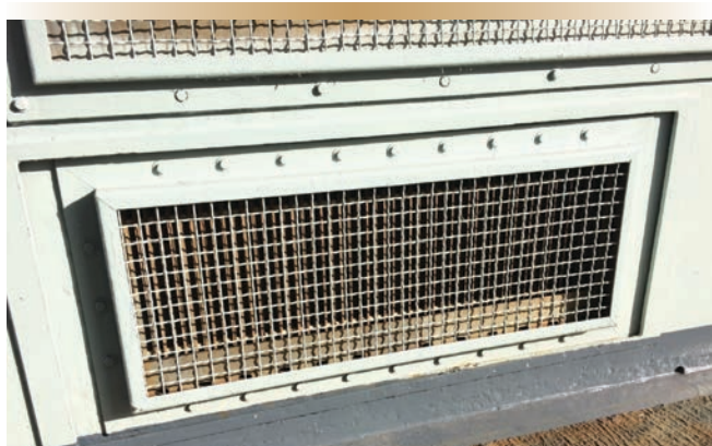
Figure 2. Un louvre de contournement d'admission d'air actionné manuellement.
