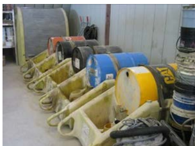
Figure 4 : Diques séparées pour confinement secondaire pour des HAZMAT
