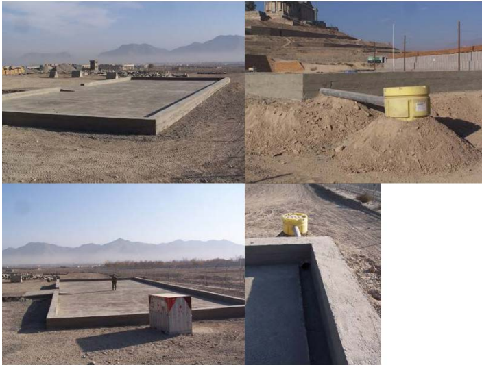
Figure 7 : Exemple de plateforme d'assainissement du sol
