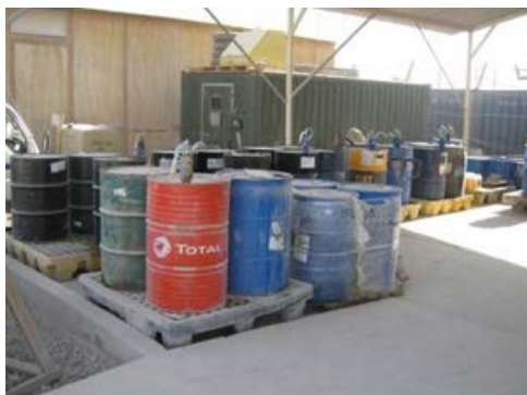
Figure 3 : Confinement secondaire combiné pour des HAZMAT
