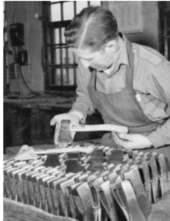
**Figure 15** Ouvrier de la Walters Axe Company, de Hull (Québec), vérifiant la qualité des haches avant leur expédition, en 1961
