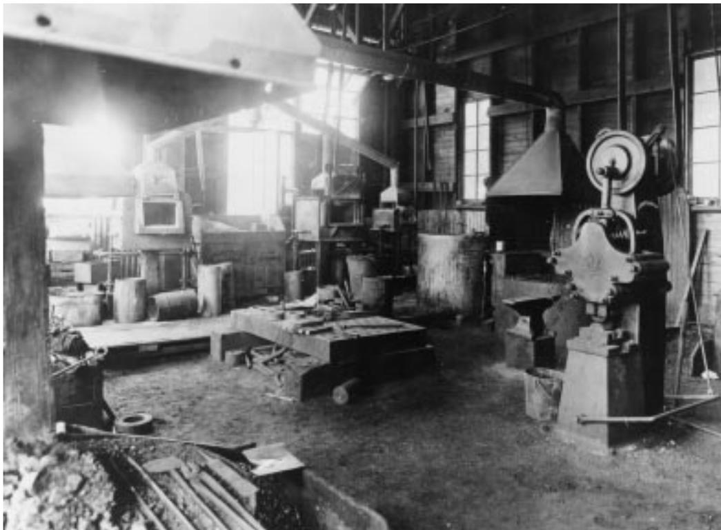
**Figure 17** Forge aménagée à l'intérieur de la Bawden Machine Company pour la fabrication de matrices, Toronto, vers 1917
