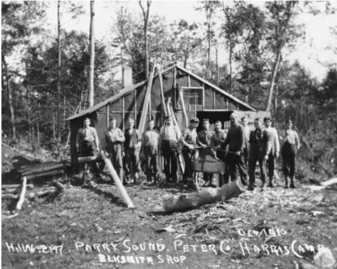
**Figure 27** Forge aménagée sur le chantier de la Peter Company à Parry Sound (Ontario), pour la réparation des haches et des autres outils forestiers, en 1910
