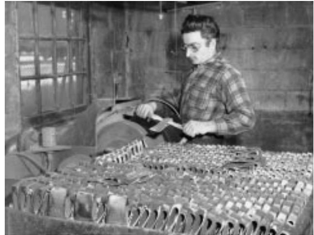
**Figure 14** Ouvrier de la Walters Axe Company, de Hull (Québec), affecté au polissage des haches à la meule, en 1961
