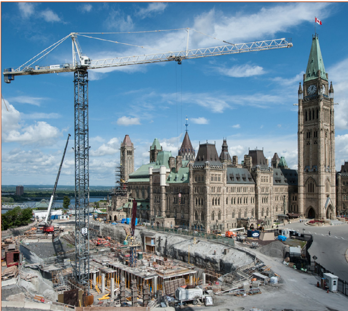
Construction de la phase 1 du Centre d'accueil des visiteurs
