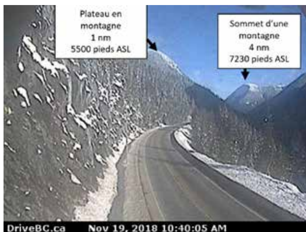
Figure 5. Vue vers le nord-est saisie à 10 h 40 à la galerie paravalanche Jack McDonald (3050 pieds ASL), à 22 nm au nord-est de CYRV, le 19 novembre 2018 (Source : DriveBC.ca, avec annotations du BST)
