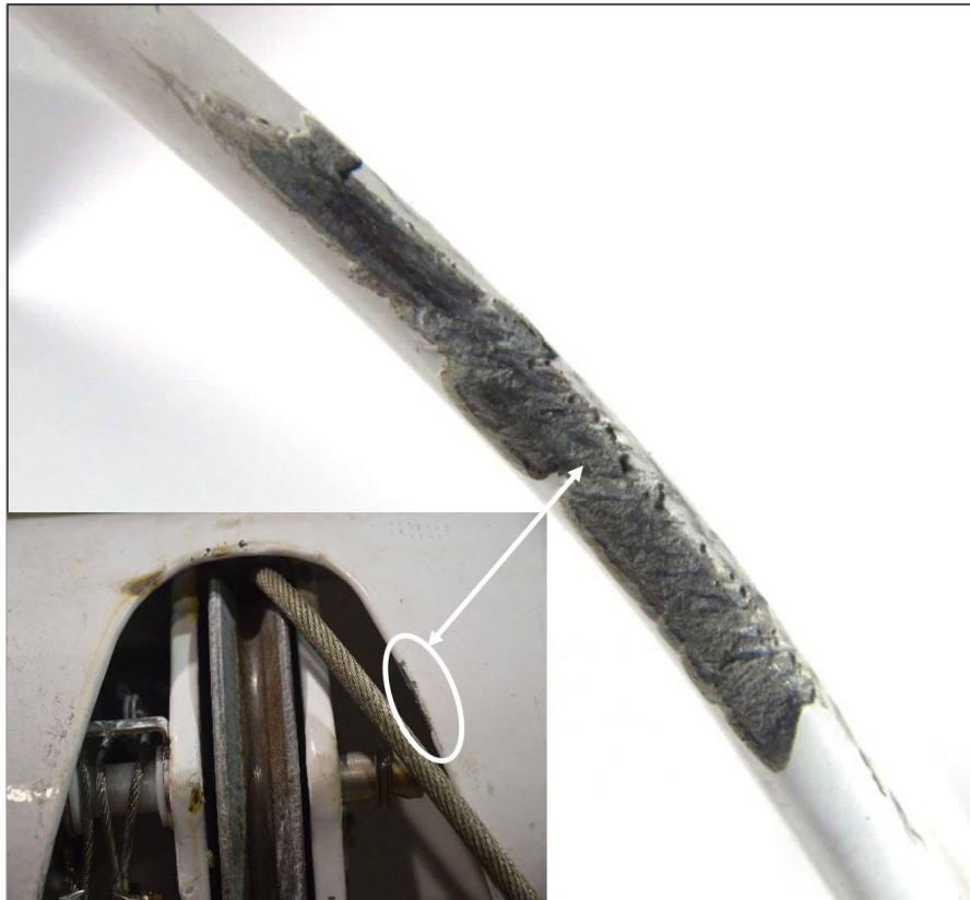
Figure 11. Dommages au côté droit du couvercle de la roue à gorge (Source : Acuren Group Inc.)
