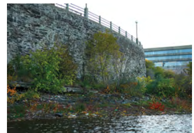
Plus de 600 structures différentes (p. ex., murs de soutènement, plateformes de belvédère, barrages...)
