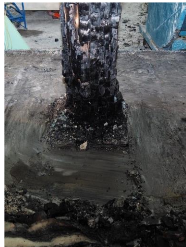
(d) bottom portion of Glulam column
