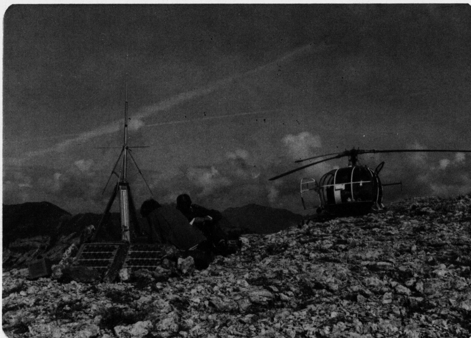
FIG. 8. Mount Russ satellite receiving station powered with solar cells. Station de réception à satellite, actionnée par piles solaires, au mont Russ.
