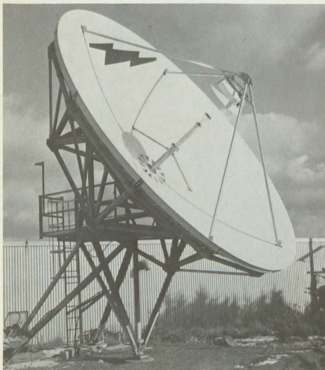
Antenne Andrew de 2,4 m en 4 GHz pour stations de télévision réceptrices au sol installée au siège de Whitby (Ontario).
