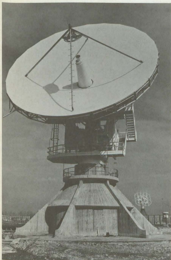
Antenne de poursuite des satellites TTC & M de 16,5 m fabriquée par TIW Systems .
