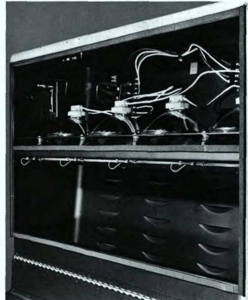
Regardant dans un groupe VASIS montrant les quatre unités de lampes produisant un faisceau "Sealbeam" sur leurs supports ajustables à ressort. • Looking into a VASIS unit showing the four sealbeam lamp units on their adjustable spring mountings. • Vista de una unidad VASIS, mostrando las cuatro unidades de iluminación selladas por separado, sobre sus bases de resortes.
