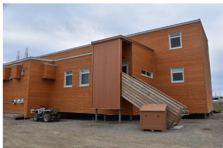
Figure 1 : Résidence triplex à la Station canadienne de recherche dans l'Extrême-Arctique (SCREA), où le système d'eaux grises sera installé en novembre 2018.
