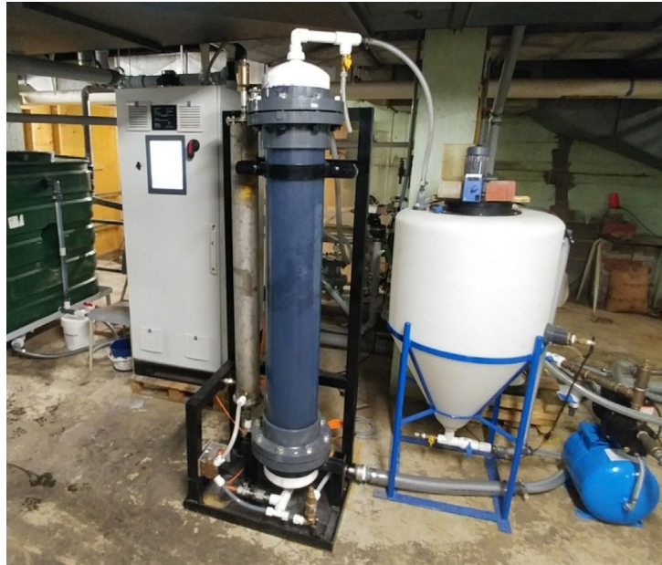
Figure 3 : Installation du système de traitement des eaux grises lors de l'évaluation effectuée à Montréal.
