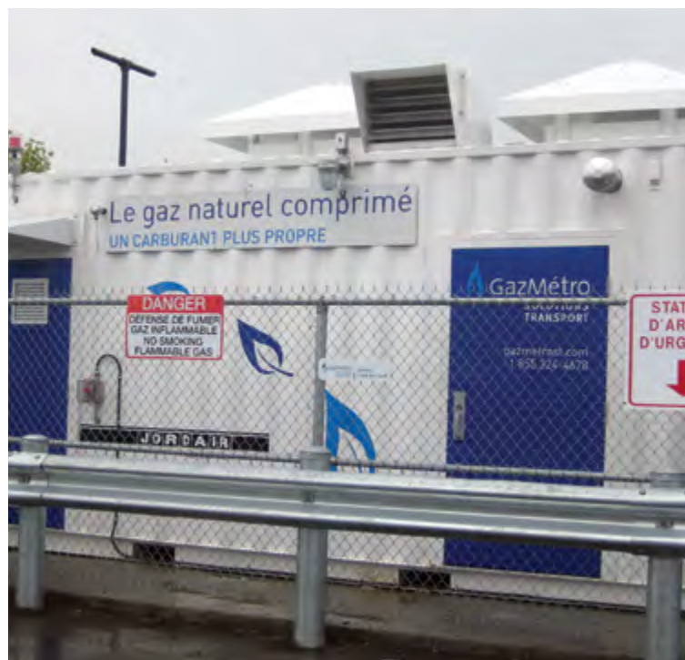
Compresseur de GN Jordair – Énergir (anciennement Gas Métro) et installations de ravitaillement à Québec, Qc
