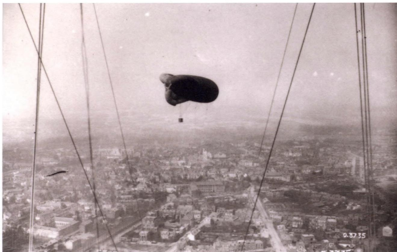
Ce ballon cerf-volant au-dessus d'Arras, en France, aide les cartographes à recueillir des renseignements cruciaux sur les lignes allemandes. Un câble d'acier relie l'aérostat chargé d'hydrogène hautement inflammable à un treuil mobile au sol qui le ramènerait au lieu de décollage, ainsi que son occupant, s'il était touché par un tir ennemi.
