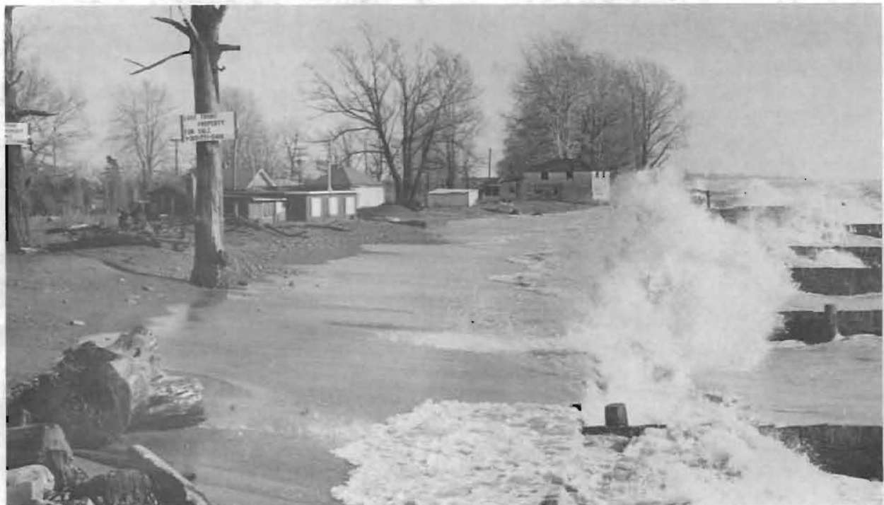
Figure 21: Exemple de protection du rivage le long du Dyke Road, township de Harwich. Ces brise-lames construites en 1969 ne furent pas très efficaces.
