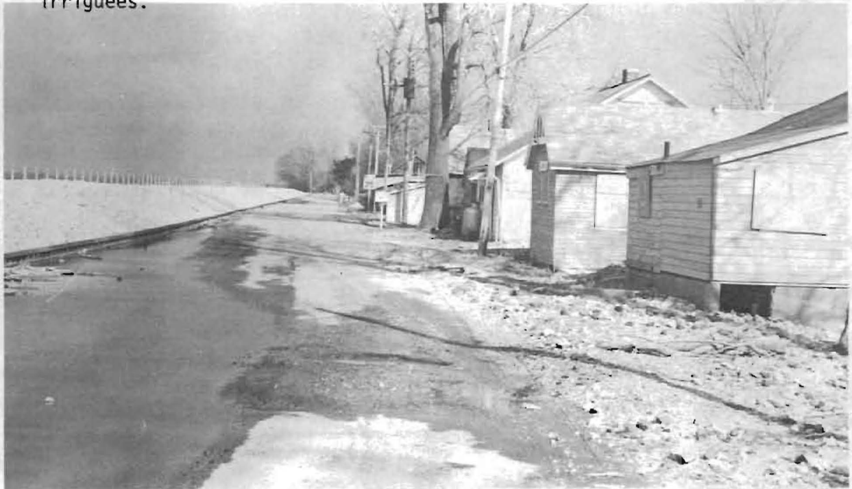
Figure 24: Exemple de protection des rives, Dyke Road, township de Harwich. Par suite de protestations répétées de la part des propriétaires de chalets, cette digue fut construite à l'intérieur des terres par rapport aux chalets.
