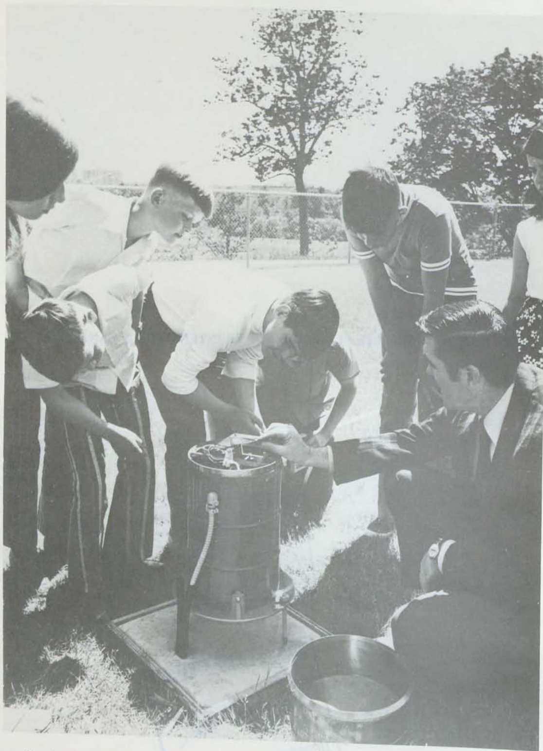
Examen du mécanisme des augets basculeurs d'un pluviomètre enregistreur. La surface collectrice de la pluie est déterminée par l'ouverture d'un entonnoir cylindrique que l'on peut voir posé au premier plan. Les données analysées dans ce rapport sont tirées de relevés faits au Canada à l'aide d'un réseau d'instruments de ce type. (La photo est fournie à titre gracieux par le ministère des Pêches et Environnement Canada).
