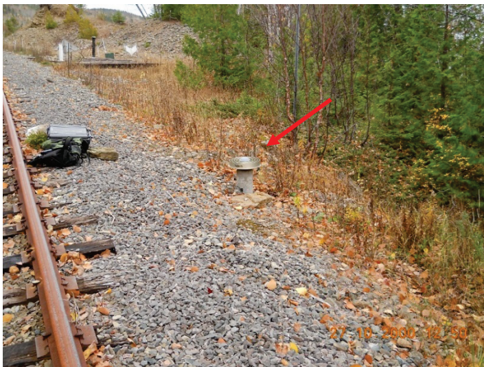
Figure 4PILIER-O-2 Vue du point Pilier-Ouest
