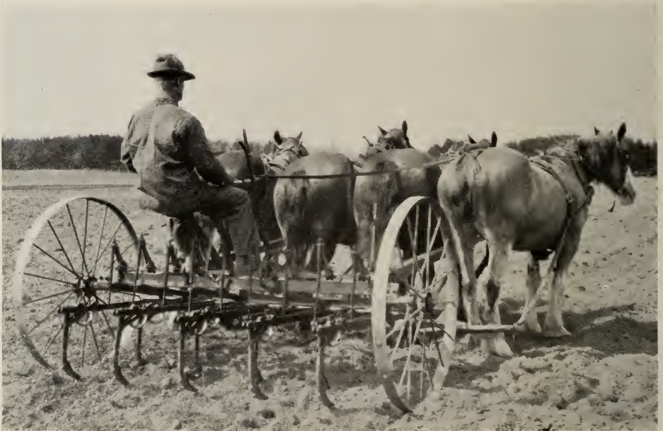
Avec un cultivateur à quatre chevaux, un homme cultive en moyenne 12.7 acres par jour, au coût de 49 cents par acre. La machine à quatre chevaux est de trois pieds plus large
