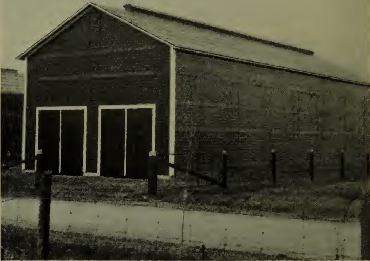
Un bon séchoir doit être bien pourvu de ventilateurs et de moyens d'approche.
