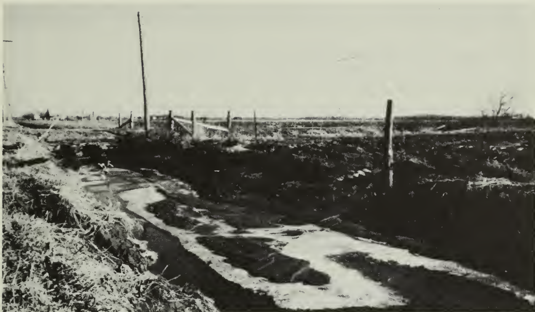
Fig. 3 La diminution de la capacité des canaux de drainage et d'irrigation constitue l'un des indices les plus évidents d'érosion des terres agricoles.
