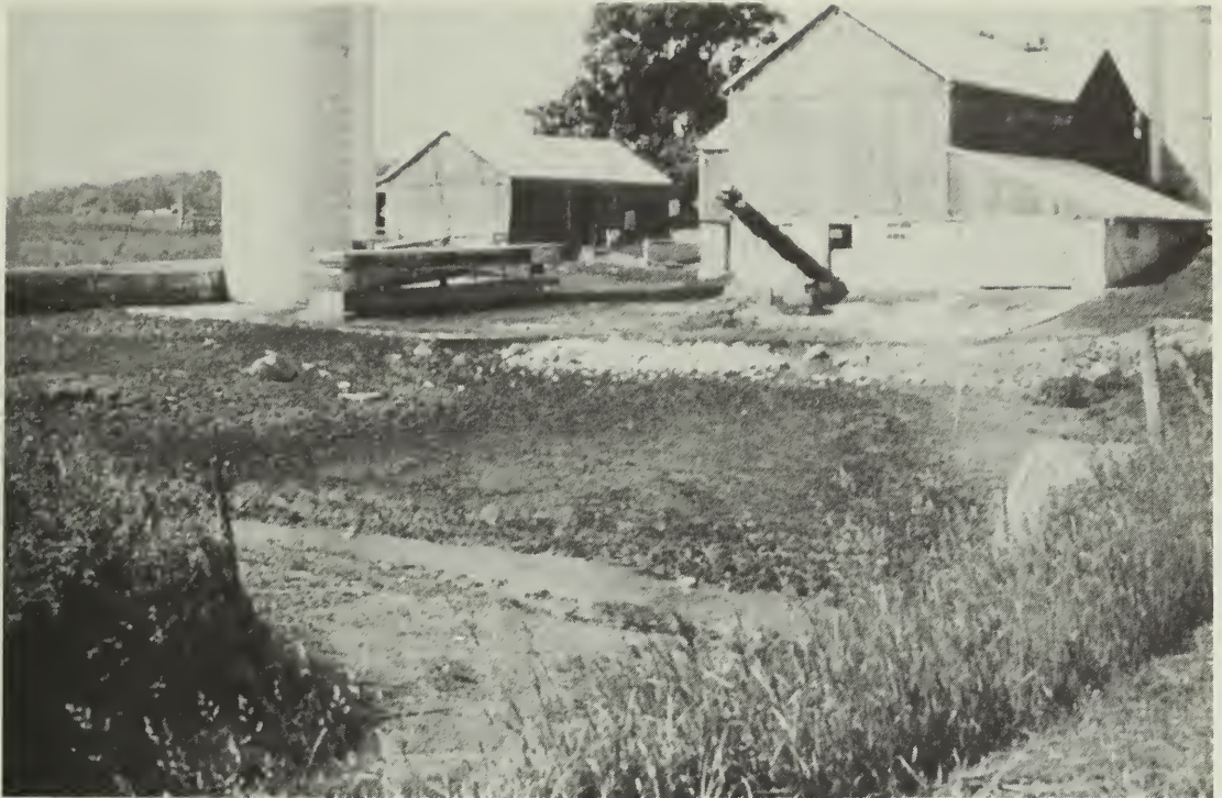
Fig. 7 Les aires de stockage du fumier et les parcs pour le bétail qui ne sont pas bien séparés des fossés et des cours d'eau, soit par la distance ou des constructions, entraînent la détérioration rapide de la qualité de l'eau locale.
