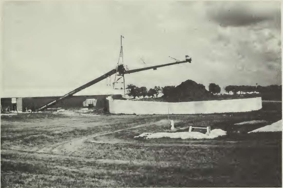
Fig. 8 Des installations appropriées de stockage du fumier comme celles-ci réduisent l'addition de liquide inutile en orientant le ruissellement superficiel loin de la zone de stockage et en empêchant l'eau du toit de pénétrer. Dans les régions à fortes précipitations, il peut être nécessaire de prévoir un toit pour empêcher les surplus d'eau de pénétrer dans les installations de stockage.
