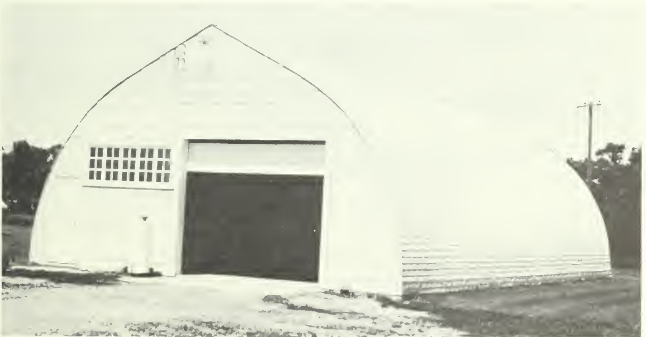
Figure 3 Modèle d'atelier à ferme en arc
