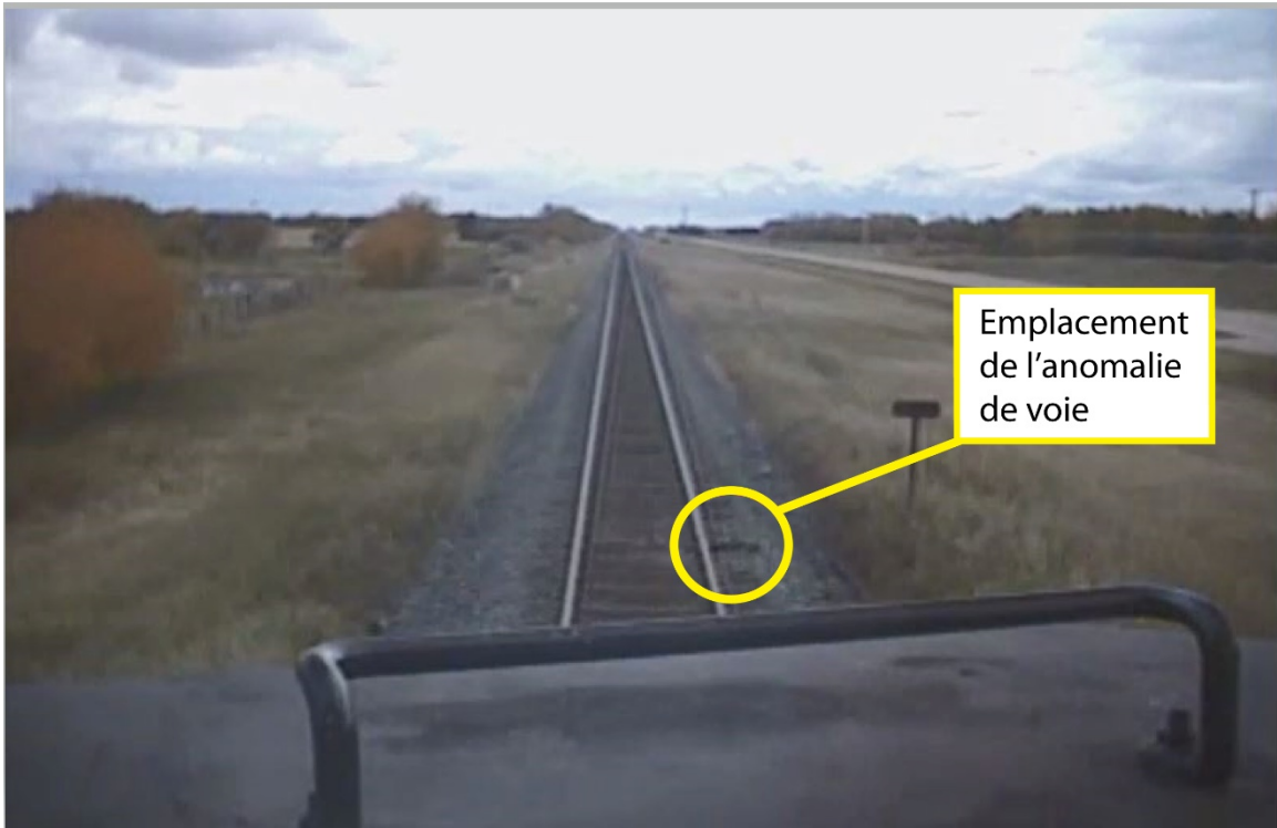
Figure 3. Vue de la caméra orientée vers l'avant du point de déraillement montrant l'anomalie de la voie; images consignées par un train précédent circulant vers l'est (Source : Compagnie des chemins de fer nationaux du Canada, avec annotations du BST)
