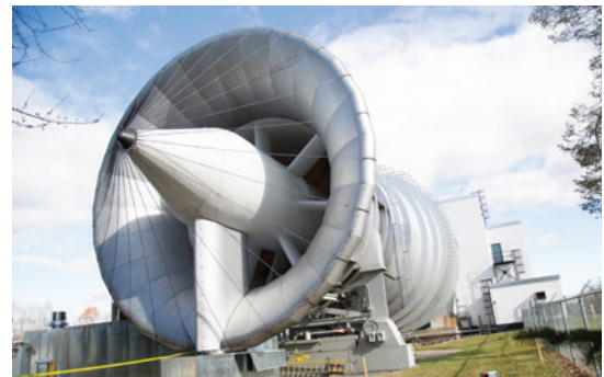
Vue extérieure de la soufflerie de givrage de 3 m x 6 m.
